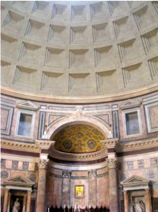
Figura 203 - L'interno del Pantheon con la cupola a cassettoni
