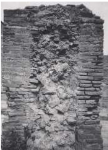
Figura 24 - Calcestruzzo antico gettato entro paramenti in mattone (Pompei)
